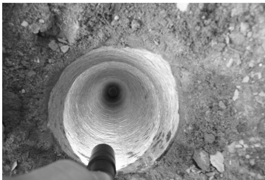
Рис 7. Визуальное освидетельствование после выбуривания керна из тела сваи.
