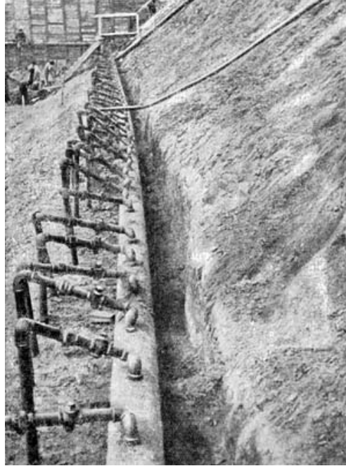
Рис 1. Выполнение водопонижения с помощью иглофильтров.
